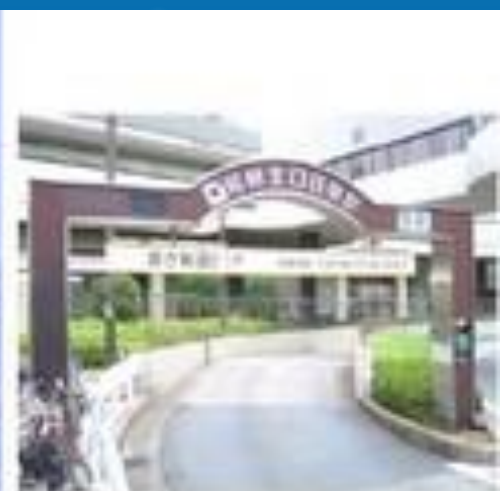
船橋北口駐車場
